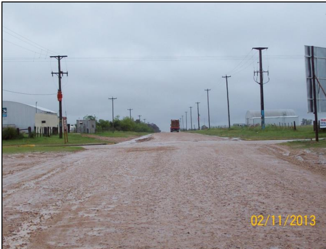
Foto 1 – Intersección Av. Padre Gallay y Villa Libertad – Vista Sudoeste-Noreste – Inicio del tramo de Obra
