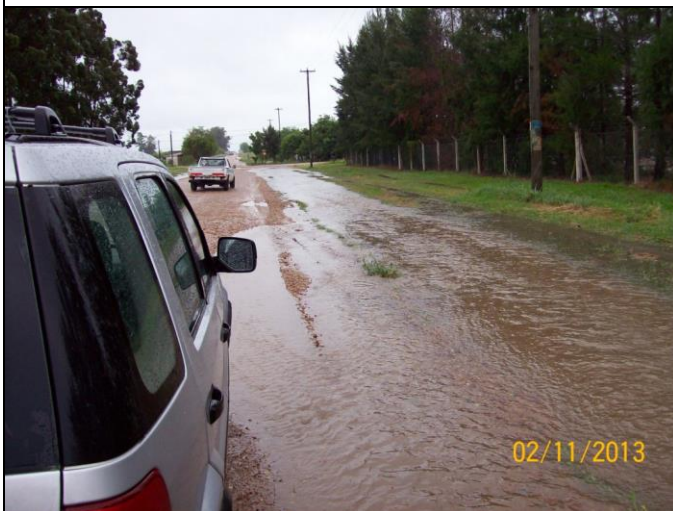
Foto 3 – Villa Libertad – Vista Sudoeste-Noreste – zona de conflicto, descarga principal de la cuenca s/lado derecho
