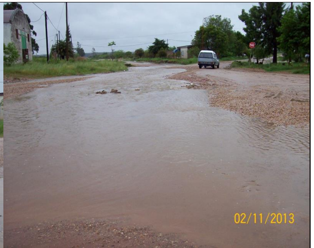
Foto 6 –Villa Libertad y 28 de Mayo– Vista Sur-Norte – descarga de las cuencas donde irá la alcantarilla
