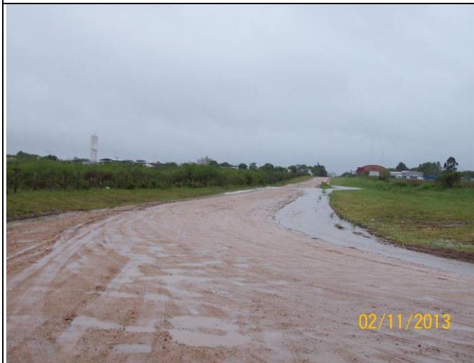
Foto 7 – Villa Libertad y Av. Siburu– Vista Oeste-Este – hacia Siburu, intersección prevista con futuro proyecto de pavimentación según planimetría.
