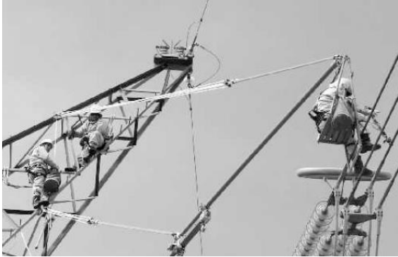
Fig. 1. Acceso de operario mediante pluma aislada anclada a estructura y dispositivos adicionales como sillín, arnés y soporte.
