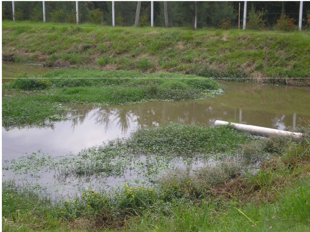
Foto 3: Detalle de vegetación existente a retirar de la Laguna Facultativa.
