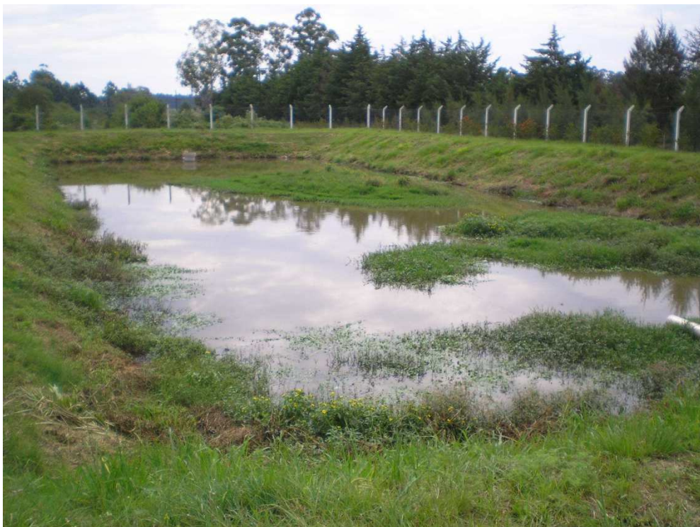
Foto2: Vista General de la Laguna Facultativa, se observa gran presencia de barros y vegetación en superficie.
