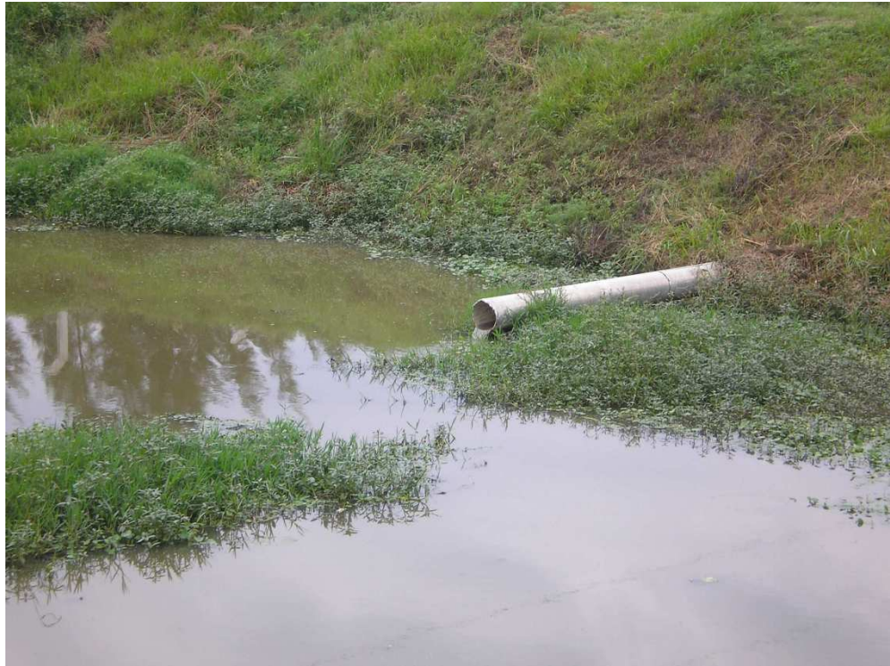
Foto 7: Detalle de vegetación e "islotos" de la Laguna facultativa.
