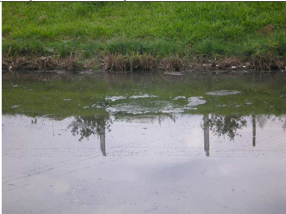
Foto 8: "ebullición" en la anaeróbica debido fundamentalmente a la falta de limpieza de barro en el fondo.
