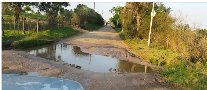
Figura 15: Zona crítica en Intersección de la avenida Unión y calle Scalabrini Ortiz.
