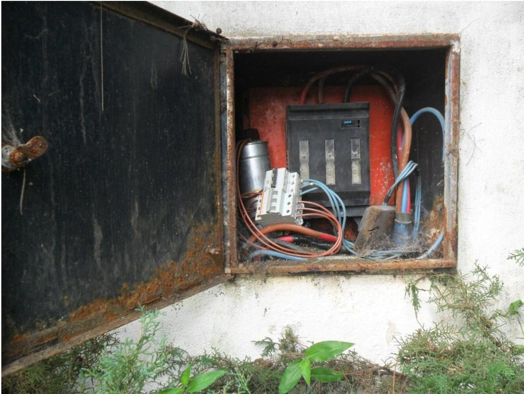
1) Este es el tablero principal, que se encuentra después del medidor trifásico de baja tensión. Como se puede mostrar en la imagen cuenta con un seccionador trifásico marca Sica que
