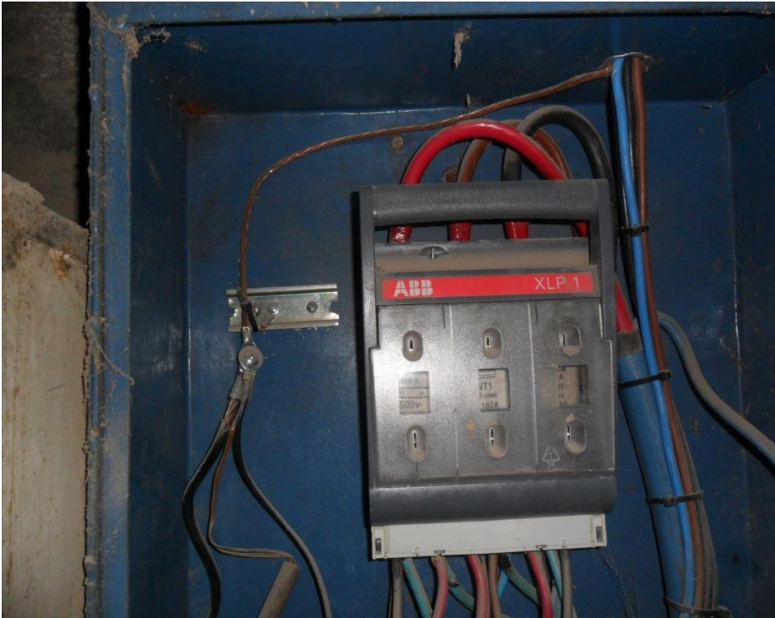
Este seccionador marca ABB de 3 polos que se encuentra aguas abajo después del tablero principal de la acometida, este es el encargado de ser el corte general de toda la planta.
