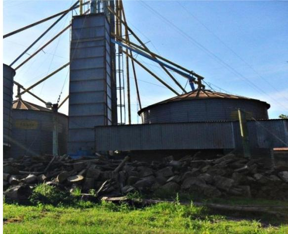
Cuando el grano ya está seco, hay una boquilla en la parte inferior de la secadora y va unos acarreadores que lo llevan a la noria 5 que se encarga de depositarlo, a los silos 1, 2, 3, 4, 5 y 6.
