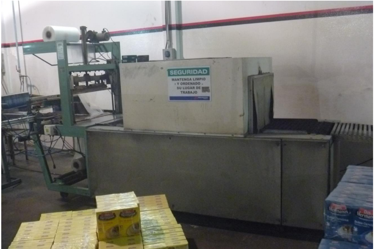
Fotografía 7: Horno de líneas 9 y 10
