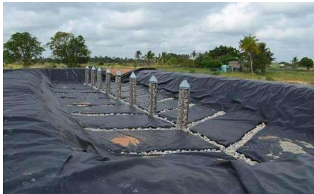
Figura 144: Conductos de ventilación Fuente: Google imagenes
