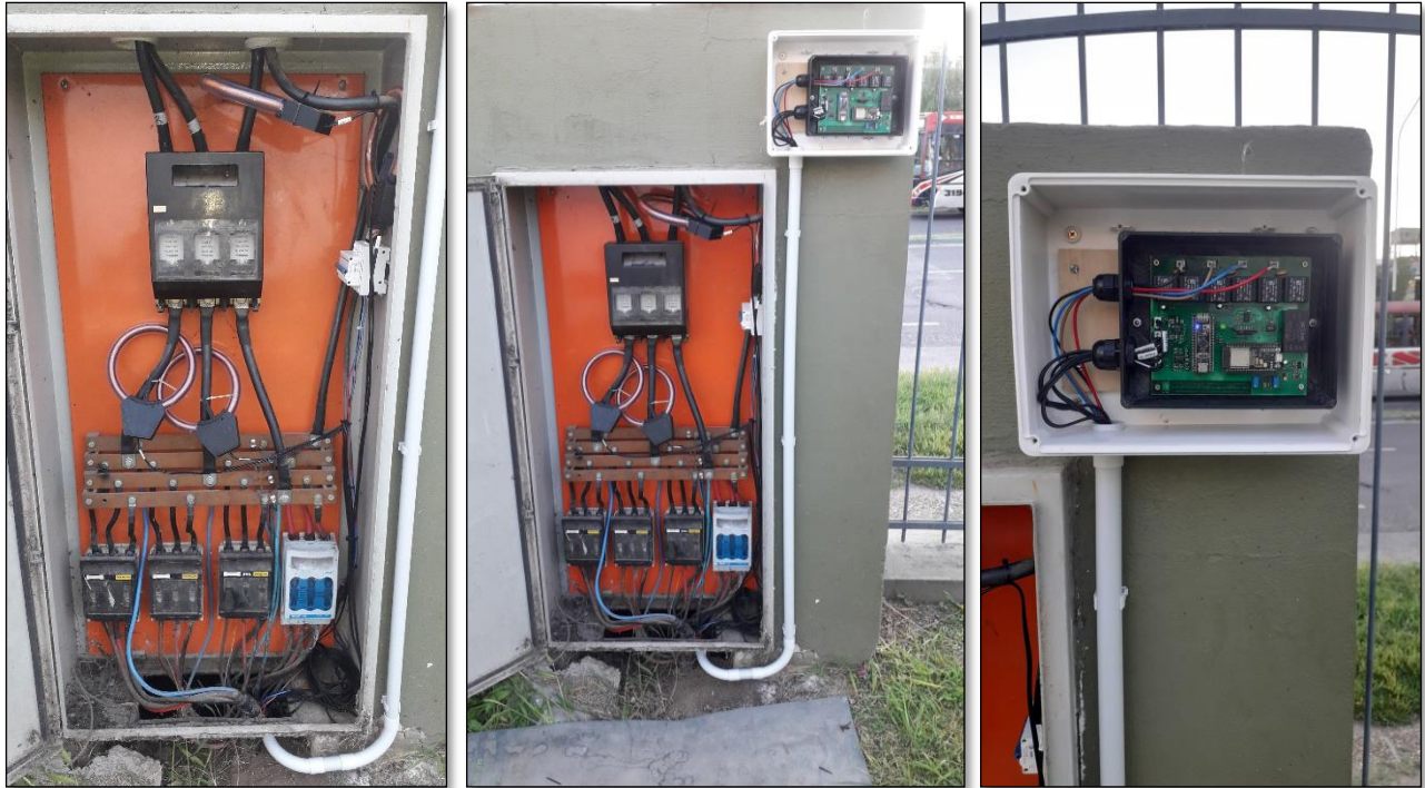
Figura 64 - Instalación del equipo junto al pilar
