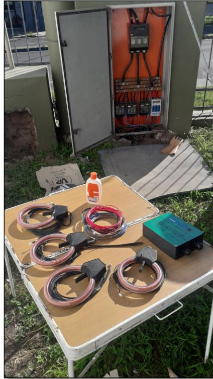
Figura 62 - Preparación previa a la instalación
