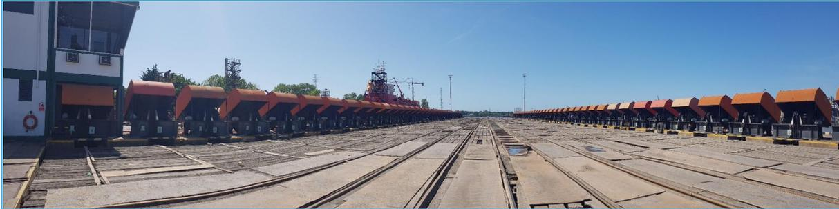
Figura 15. Durmientes del syncrolift que pueden ser removidas para el bombeo del material a dragar, sin afectar su funcionamiento.
