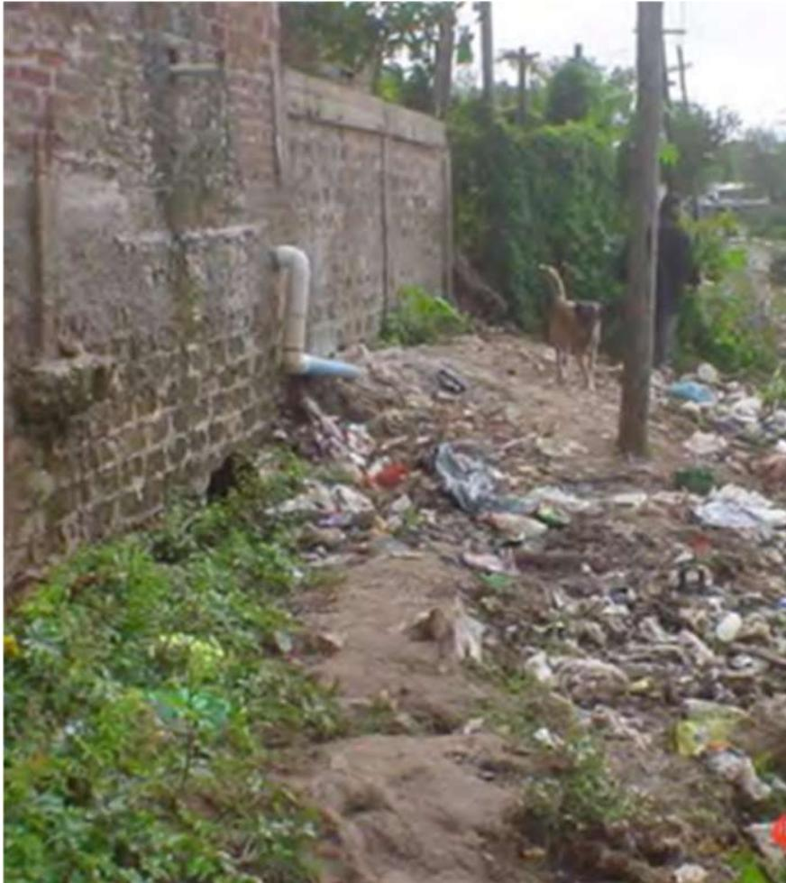
Codo saliente de una vivienda que conecta a un pozo ciego en contacto con el agua de la laguna (debajo del nivel de napa freática).
