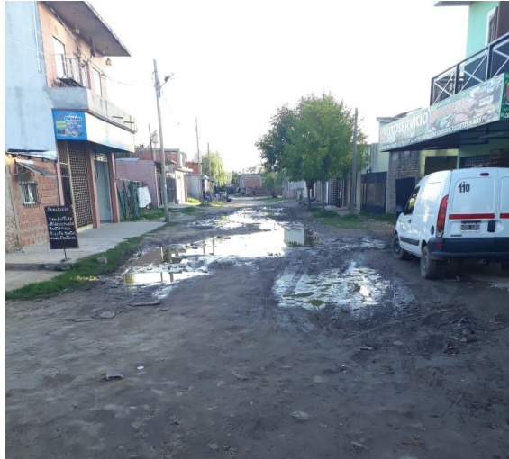
Figura 13: Calles internas inundadas
