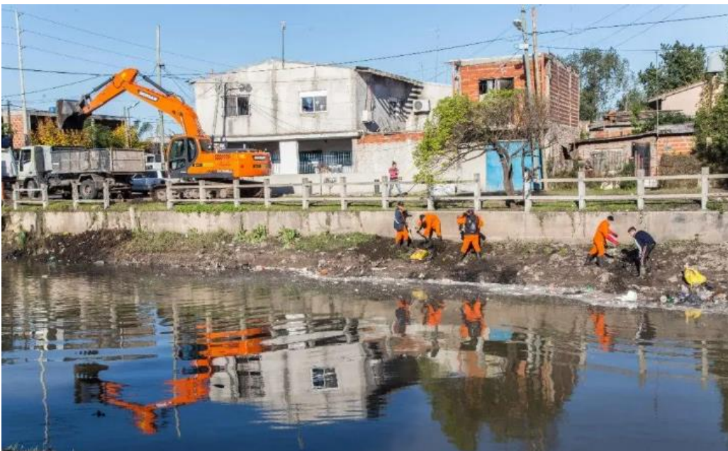
Figura 32: Retiro de residuos del Arroyo
