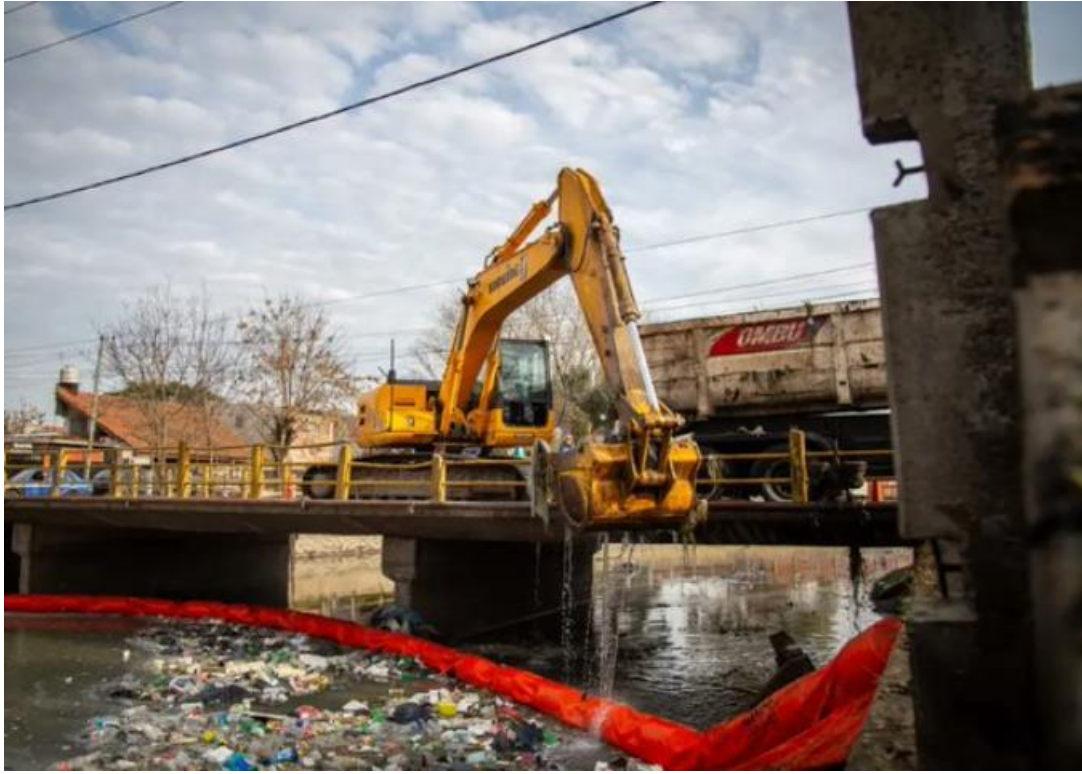
Figura 33: Limpieza del Arroyo en los puntos de colocación de barreras flotantes
