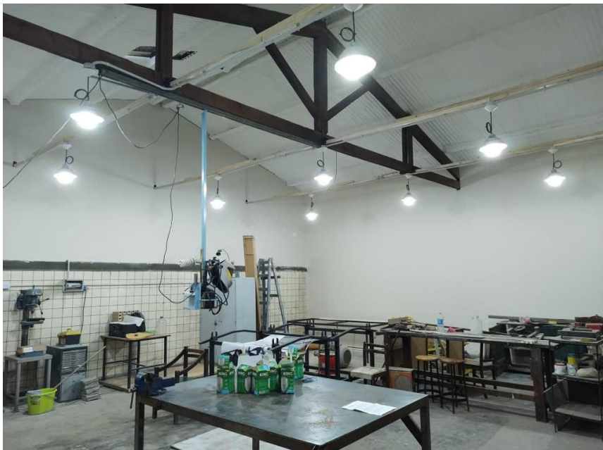
Etapa 4: Instalaciones de equipos e instalaciones eléctricas básicas. Área de INNOVACIÓN – DISEÑO
