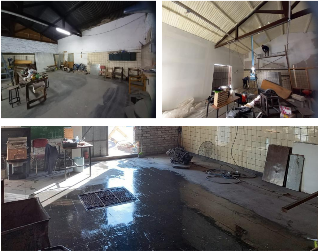
Etapa 3: Refacciones, recuperación y limpieza. Área de INNOVACIÓN – DISEÑO
