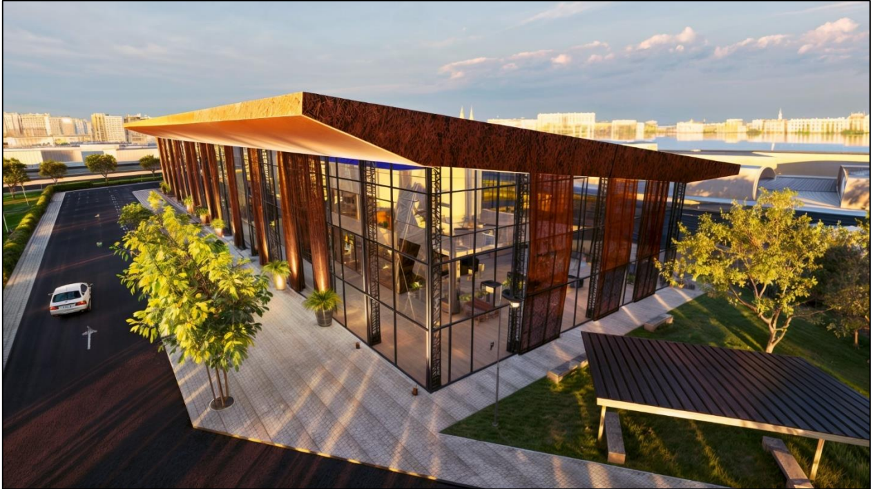
Ilustración 11-5: Vista del acceso frontal
