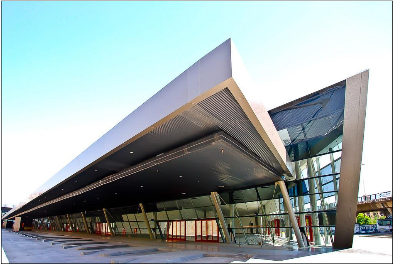
Figura 3-8: Terminal de ómnibus de la ciudad de Córdoba
