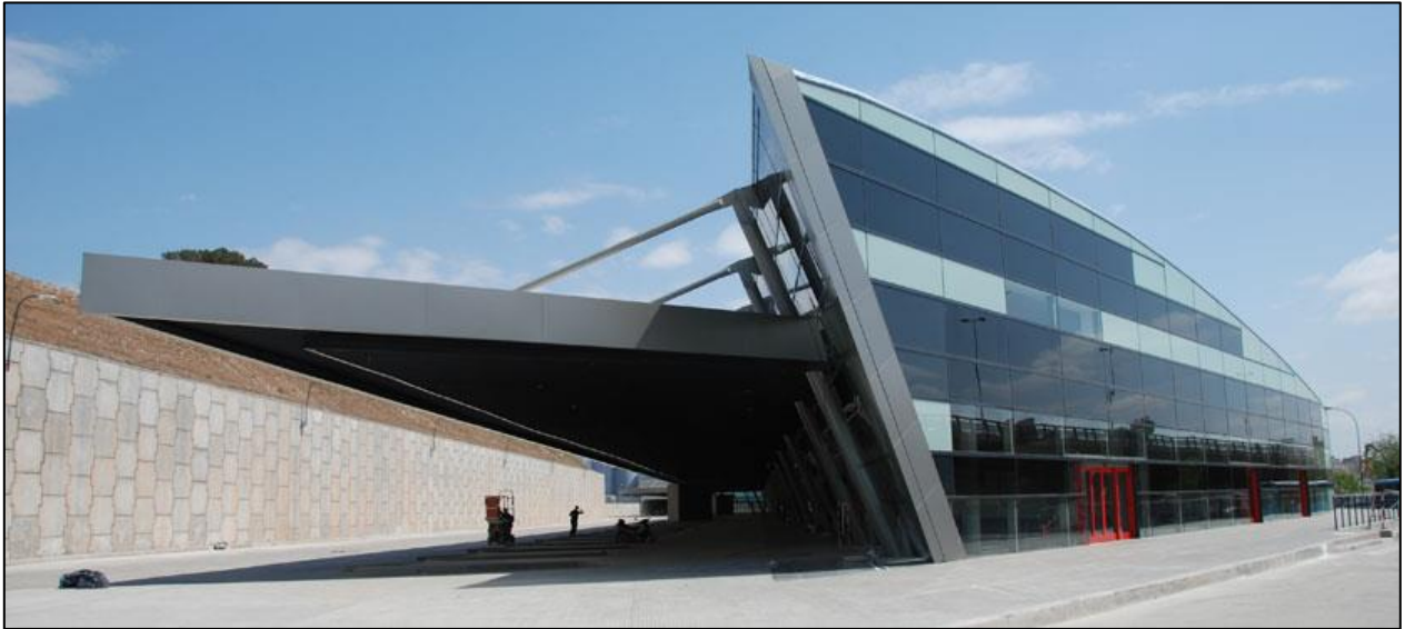
Figura 3-7: Terminal de ómnibus de la ciudad de Córdoba
