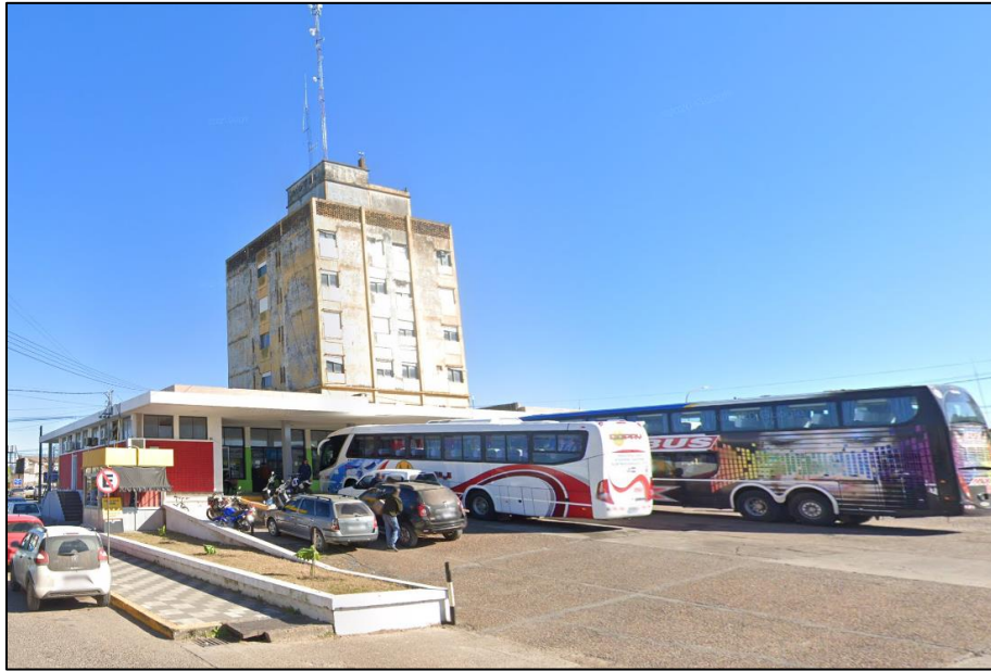
Figura 3-18: Terminal de ómnibus de Concepción del Uruguay. Vista de Dársenas
