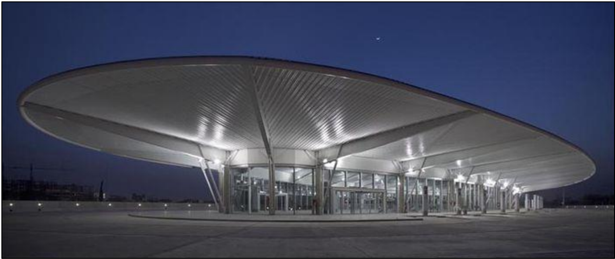
Figura 3-10: Terminal de ómnibus de Santiago del Estero
