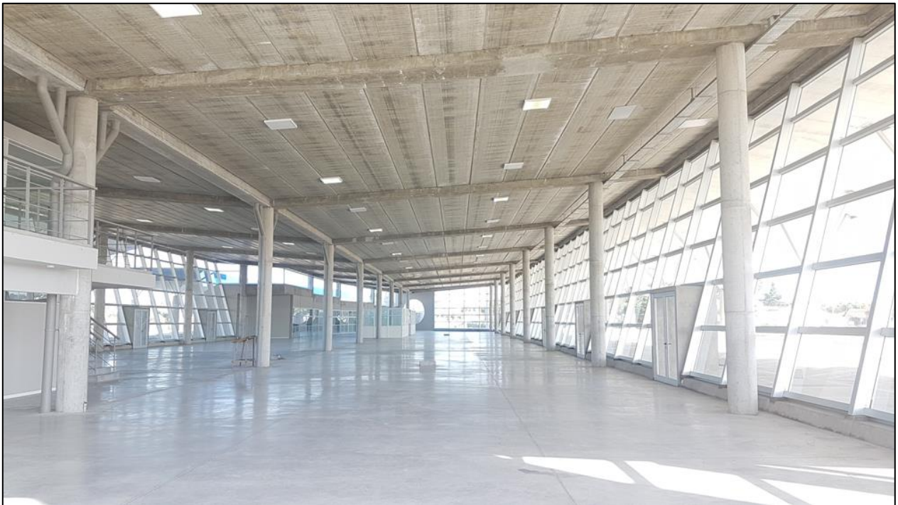
Figura 3-9: Terminal de ómnibus de Junín, Buenos Aires
