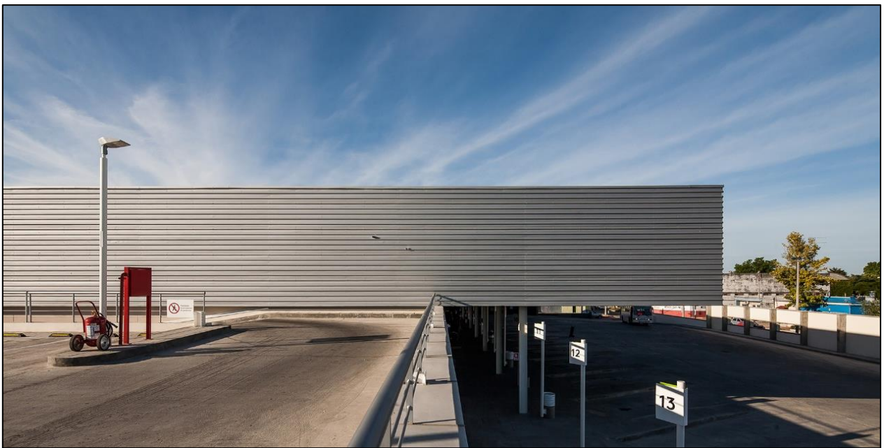
Figura 3-1: Terminal de ómnibus de Paysandú, R.O.U.
