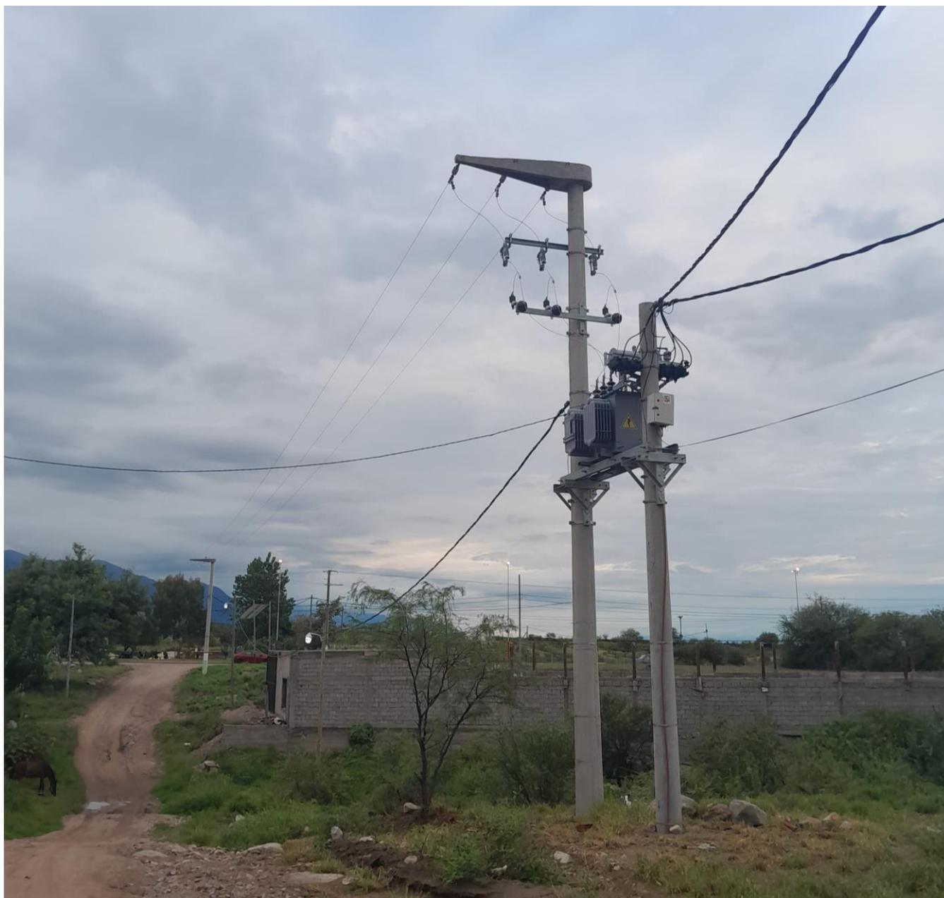
(Transformador de distribución – Potencia de 315 KVA)
