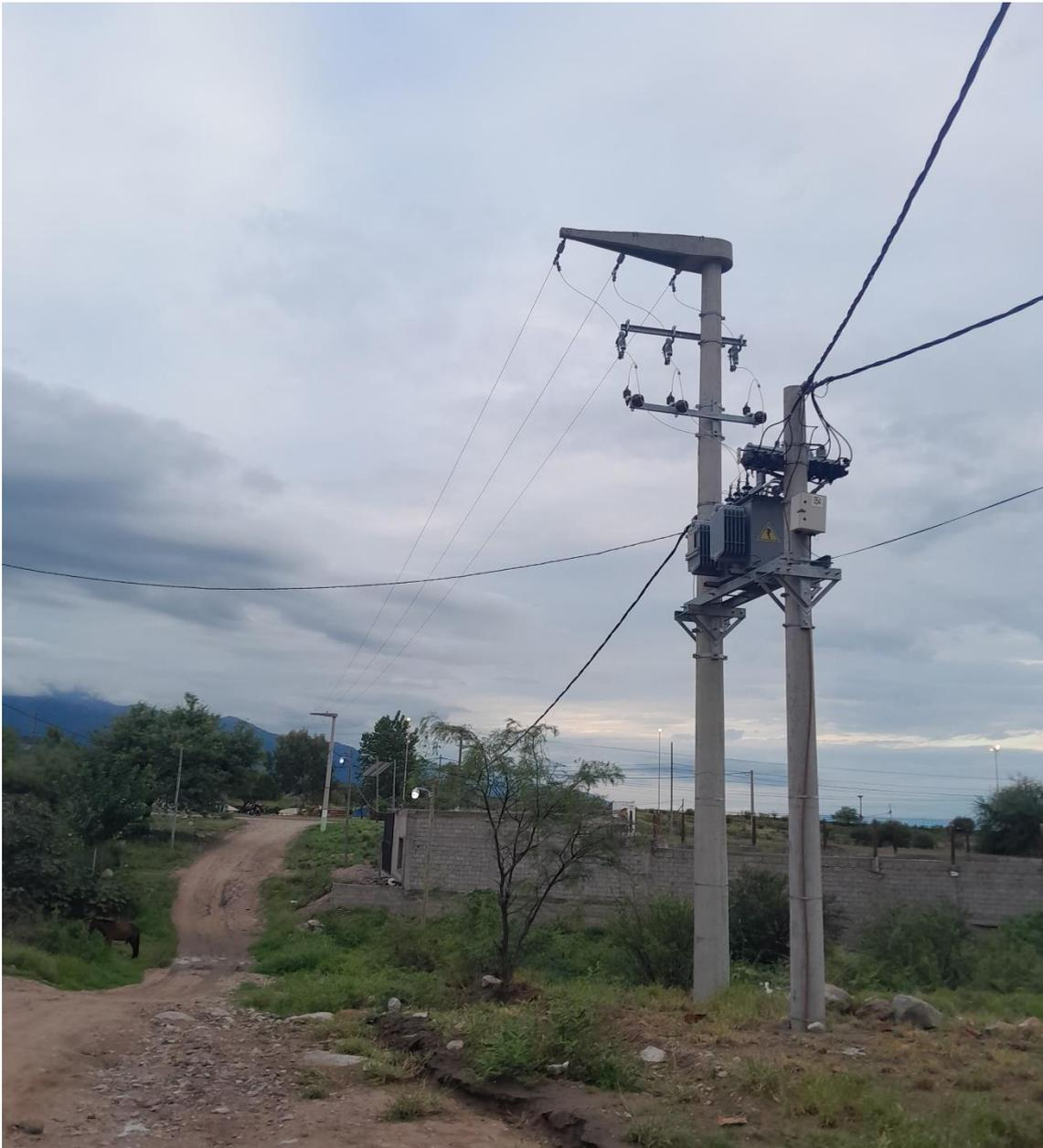
(vista Sur-norte del transformador de distribución 315 KVA)
