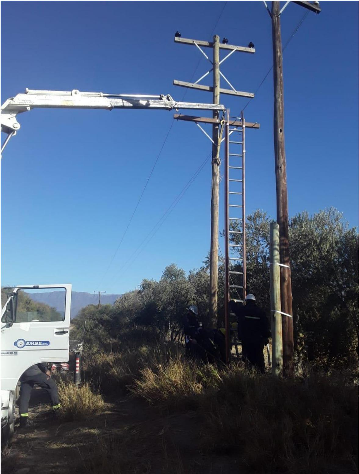
Luego los conductores se colocaron sobre los aisladores del poste nuevo y se procedió a atarlos con alambre para atar de aluminio
