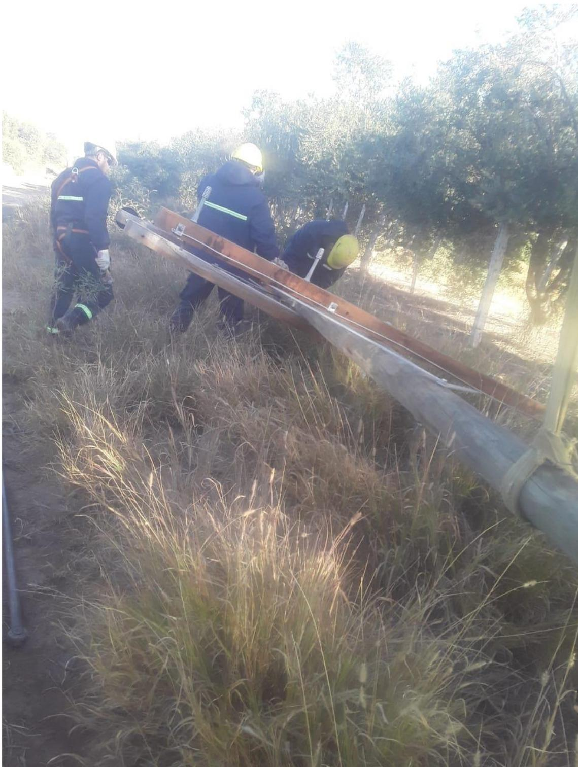
(el poste nuevo se colocó junto al dañado para luego proceder a levantarlo con la grúa)
