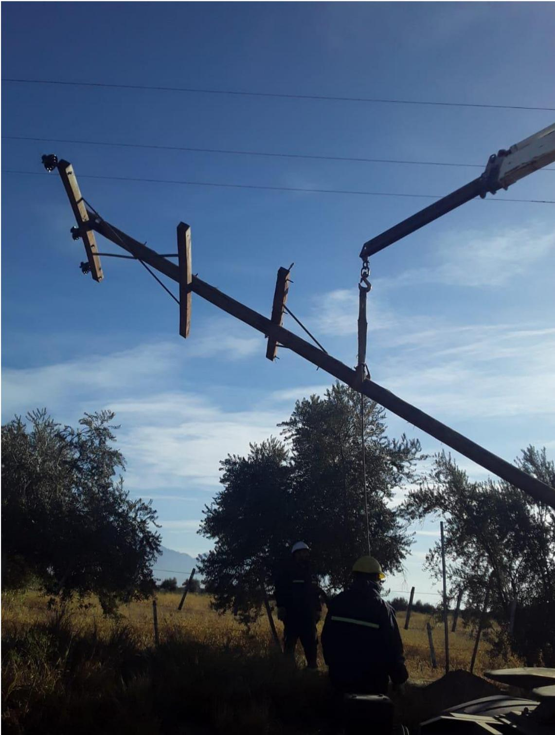
El equipo de trabajo desató los conductores de los aisladores del poste dañado para poder colocar de manera más cómoda el nuevo poste
