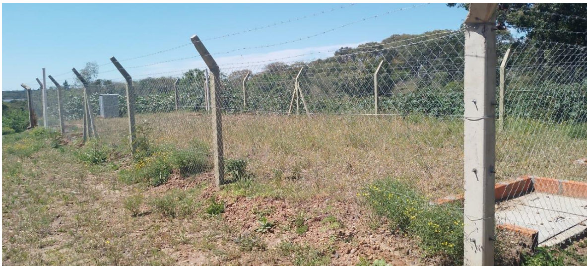
Figura 12- Sistema de Tratamiento de Líquidos Cloacales en Puerto Yerúá
