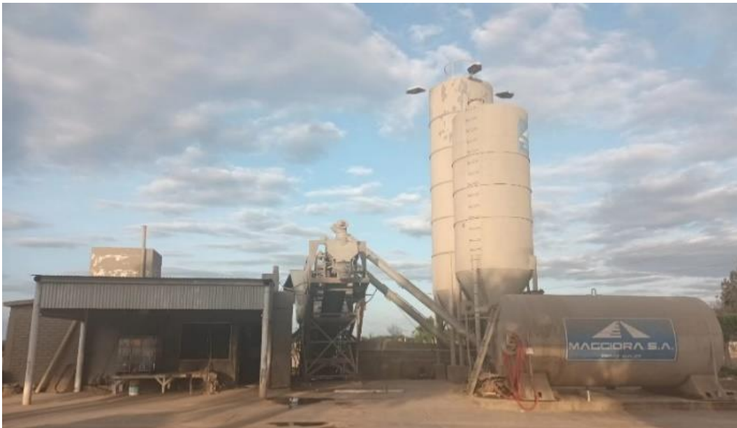
Imagen 4 Planta de Hormigón Maggiora S.A
