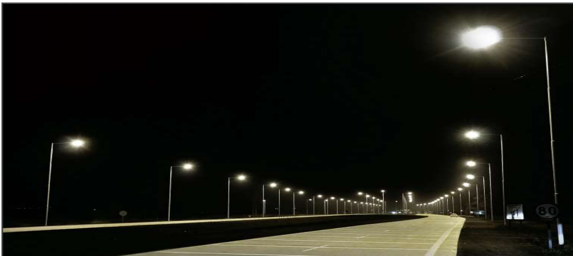
Figura 6. Mejora y readecuación del Camino Rivadavia (RP N°13). Tipo de Iluminación prevista.
