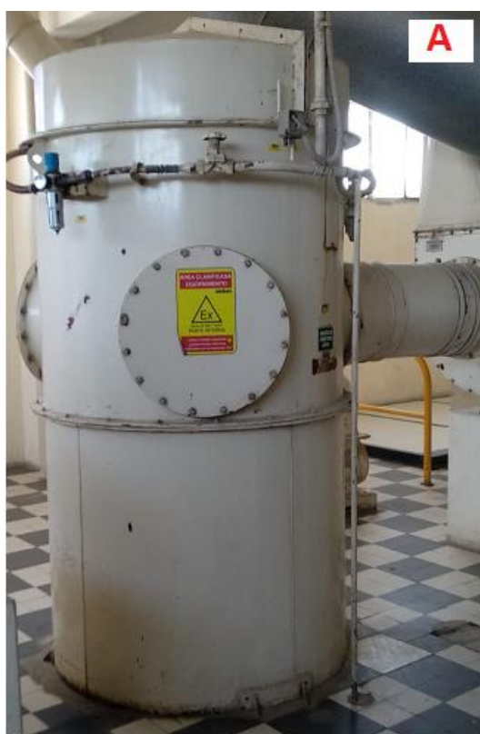
A - Foto filtro de mangas (2do piso) B - Foto descarga filtro de manga y válvula rotativa (1er piso)
