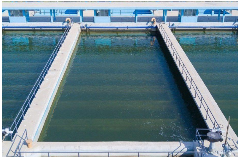
Fig.55: Filtro de Arena Lento (FACSA).
