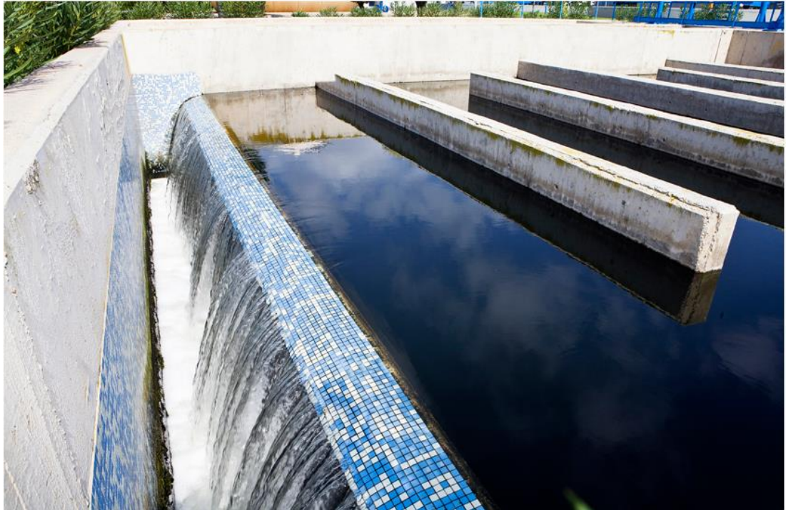
Fig.56: Laberinto de cloración (TECPA).
