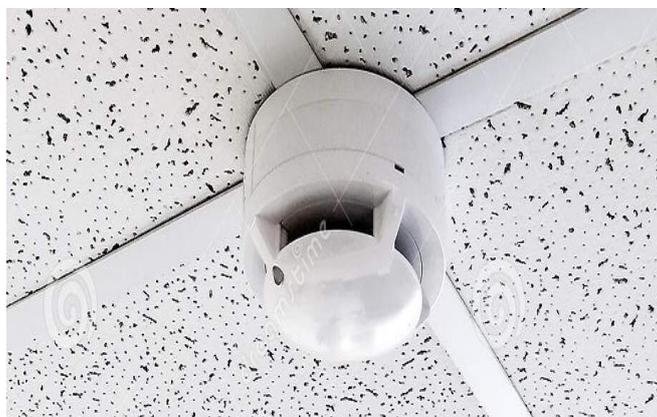
*Ilustración 5 - Sensor extractor de humo*
