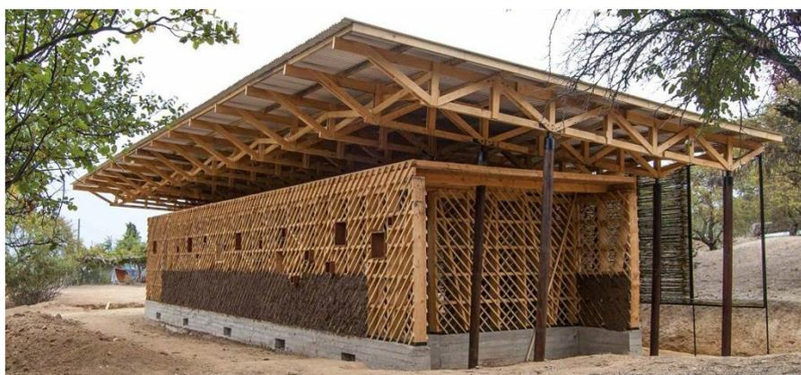
**Figura 1:** Embarrado de una vivienda construida con técnicas mixtas
