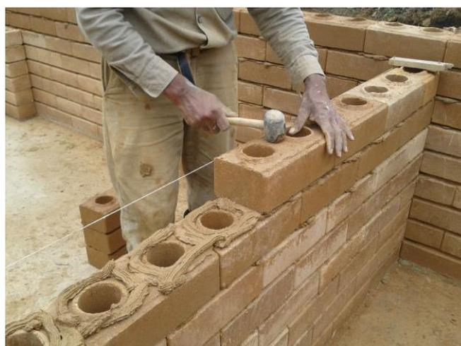
**Figura 3:** Construcción de un muro con bloques de tierra comprimida (BTC) en Federal, Entre Ríos
