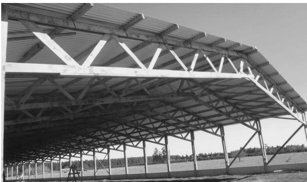
Figura 4. Estructura reticulada de 16m cuyas conexiones se materializaron con clavos de pequeño diámetro colocados neumáticamente
