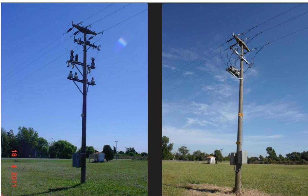
*Imagen 5: Medición comercial en 13,2kv (de montaje convencional al nuevo tipo de montaje).*
