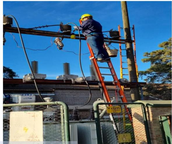
Maniobras en un emplazamiento de medición de 33kV de tipo constructivo convencional
